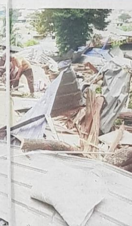
ABDUL WAHID bersama ayahnya, Kamarudin Ismail mengutip semula barang dan kelengkapan rumahnya yang musnah dihempap pokok di Kampung Sri Gombak Indah, Batu Caves, Selangor.
